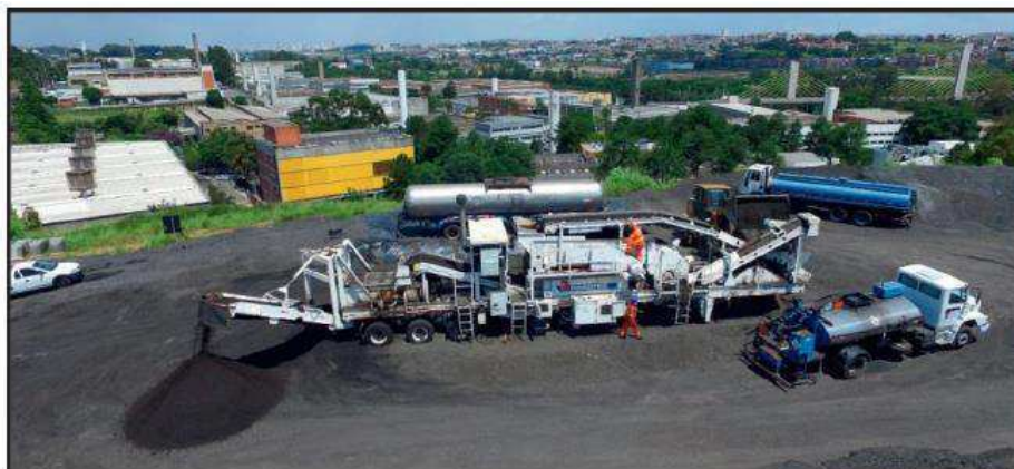
Figura 2 – Reciclagem a frio no local configurado como uma central de reciclagem a frio estacionária
