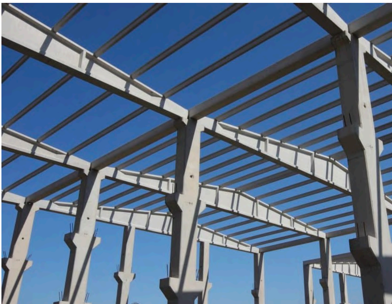
Figura 09: Coberta pré-fabricada. Fonte: Fluxengenharia [s/i].
