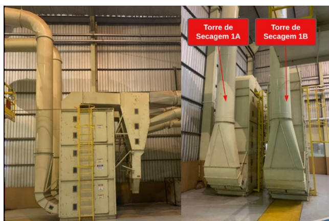
Figura 17 – Torres de secagem tipo gaveta.
