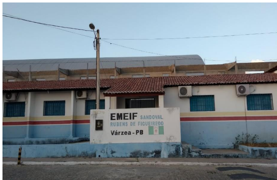
Figura 49 - Escola Sandoval Rubens de Figueiredo (Cidade) – em funcionamento
