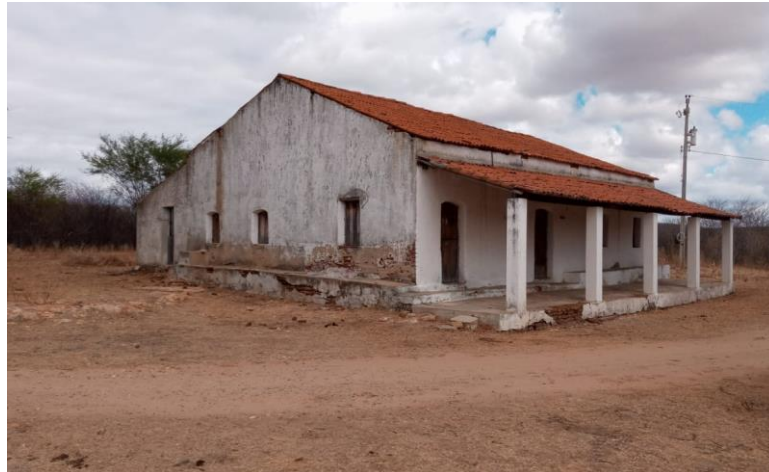
Figura 15 - Antiga escola João Jorge de Araújo (Desativada)
