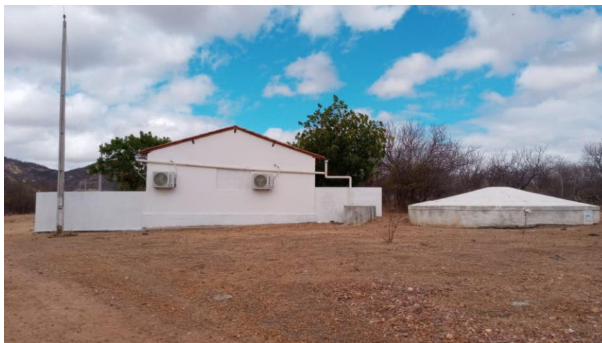
Figura 73 - Cisterna utilizada para armazenar água da EMEIF José Inácio de Moraes
