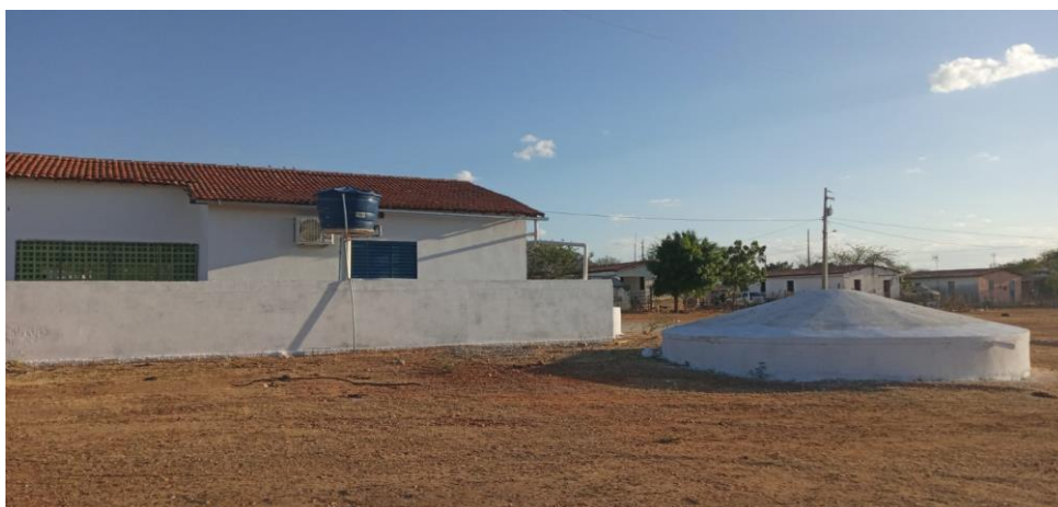
Figura 59 - Cisterna utilizada para armazenar água da EMEIF Cristina Elizeu de Medeiros
