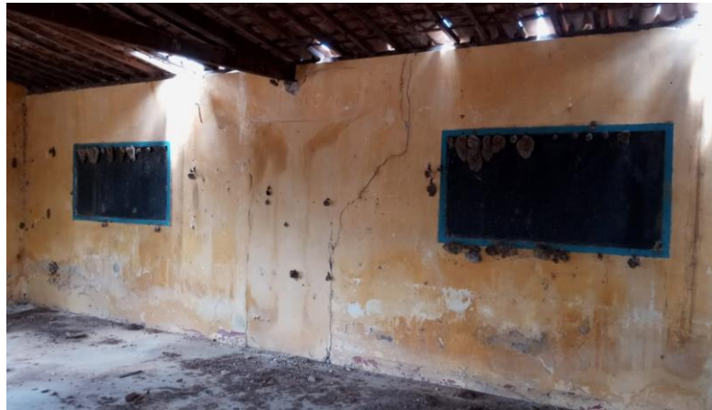
Figura 41 - Sala de aula Multisseriada - Escola Manuel Genuíno de Araújo
