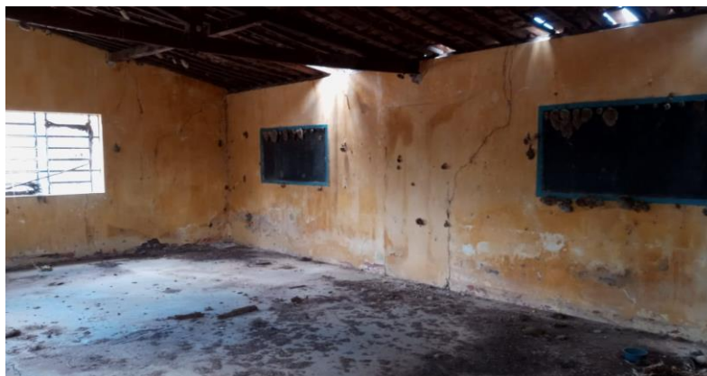
Figura 42 - Sala de aula Multisseriada - Escola Manuel Genuíno de Araújo
