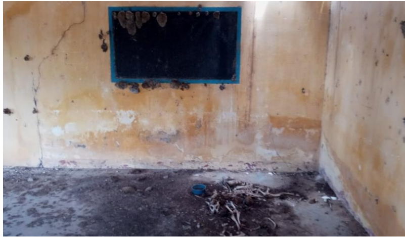
Figura 43 - Sala de aula Multisseriada - Escola Manuel Genuíno de Araújo
