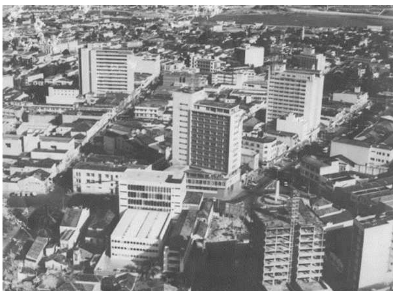
Figura 10 - Vista aérea do centro da cidade nos anos de 1960. Com visão para os edifícios Rique, Palomo e Lucas
