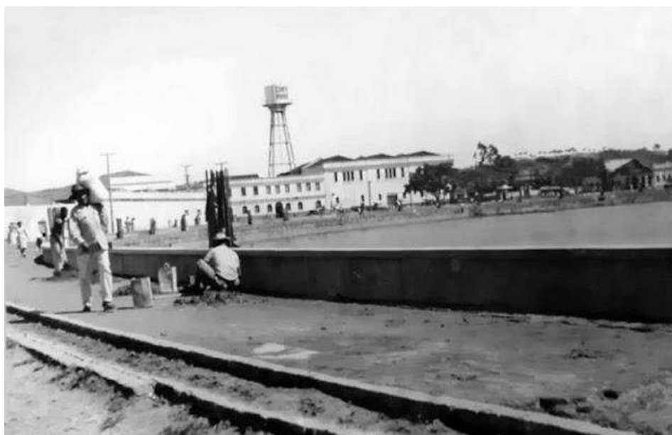
Figura 6 – Construção do cais circular do Açude Velho
