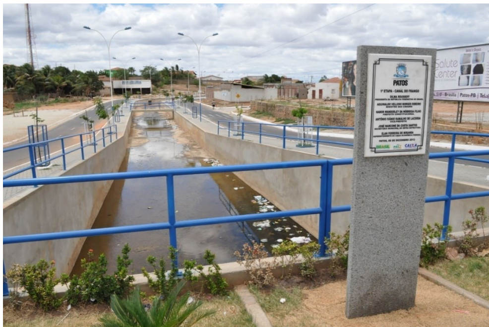
Figura 4: Canal de drenagem da Bacia do Frango.
