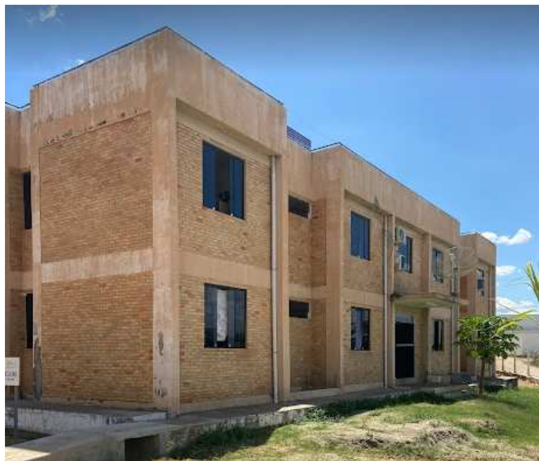
Figura 11 – Vista frontal da R. U. masculina interna do CCTA
