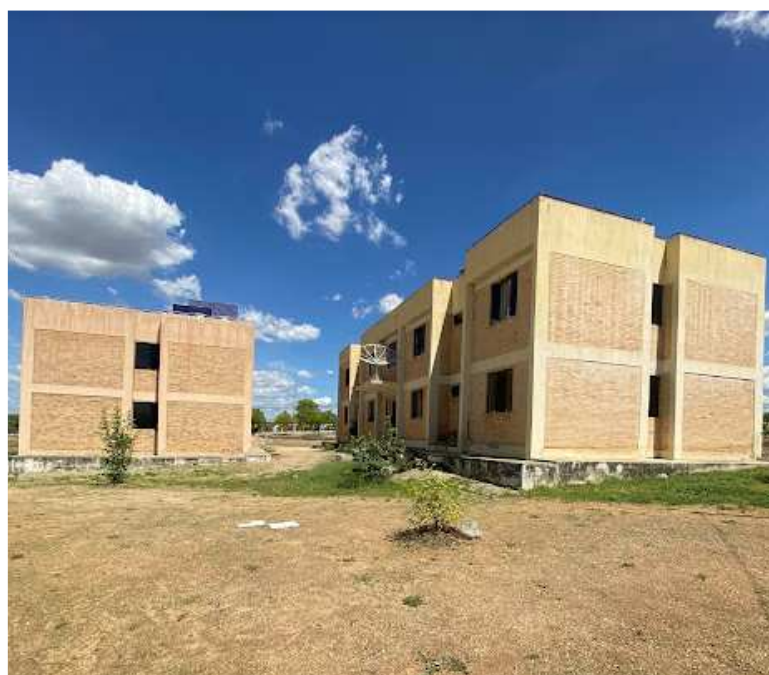
Figura 10 – Vista lateral das R. U. internas do CCTA
