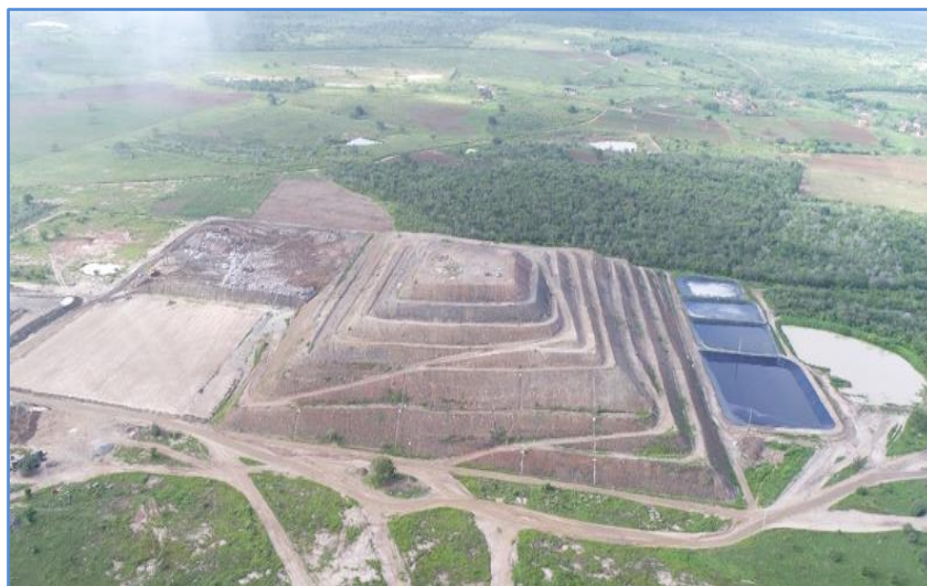
Figura 14: Visão aérea do Aterro Sanitário de Campina Grande-PB (ASCG).
