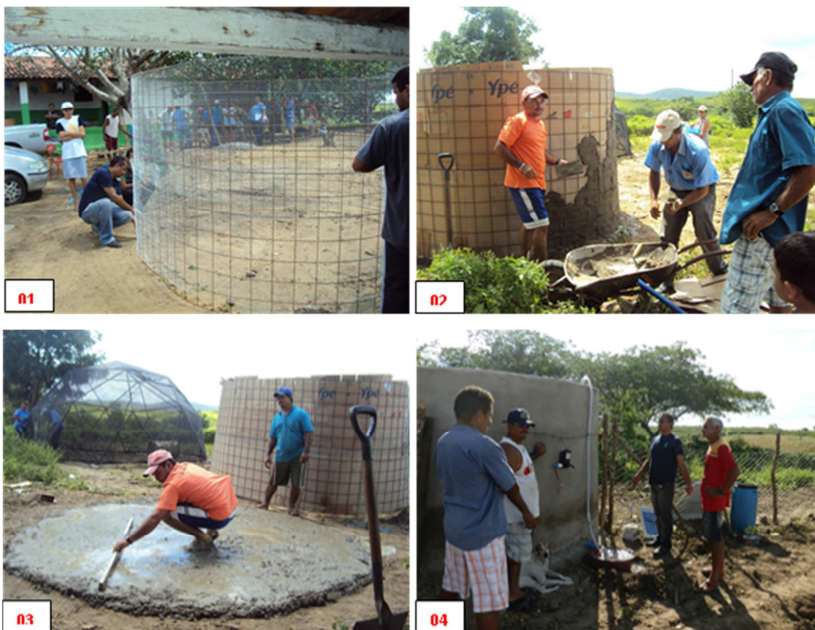
Figuras 1 a 4. Construção da cisterna alternativa da UDPAF do PA Margarida Alves I – Juarez Távora.
