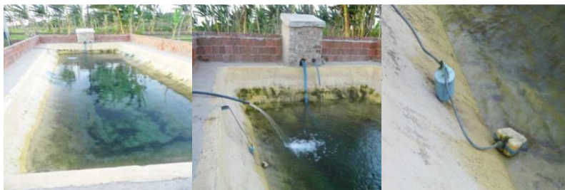
Figura 2. Reservatório de reposição de água.
