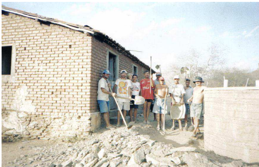
Figura 1. Primeira cisterna construída com o Fundo Rotativo Solidário na comunidade Serra Baixa, Picuí-PB
