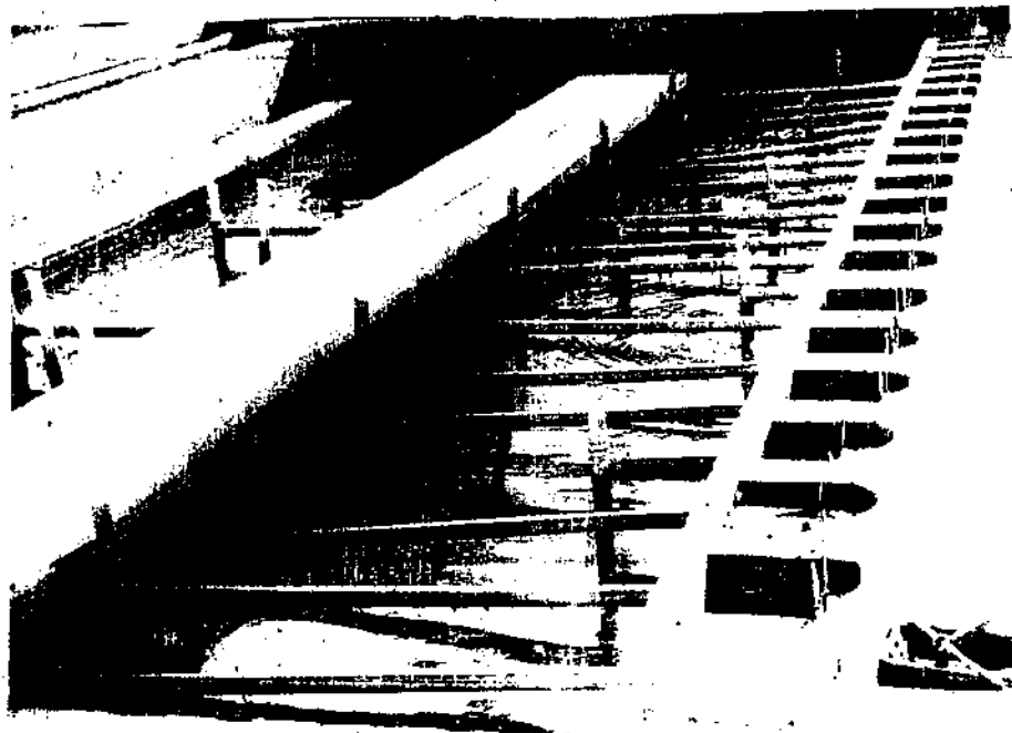
Figura 3.2 - DAFA em escala real do bairro do Pedregal mostrando as vinte caixas de divisão de vazão e as tubulações de entrada do afluente no digestor.
