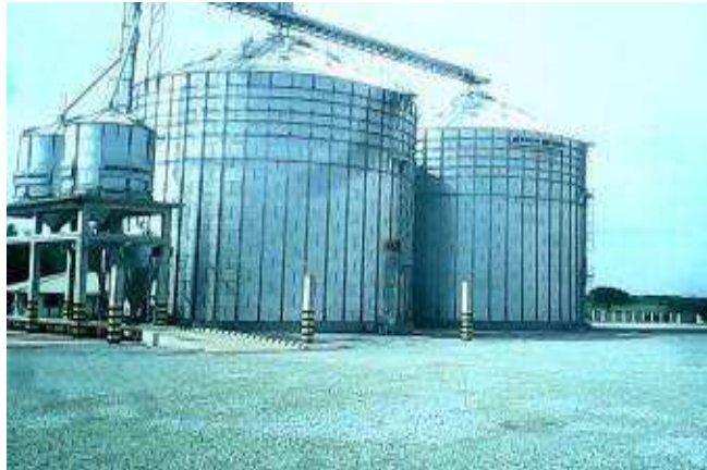
Figura 4 - Ambiente confinado visto por fora
