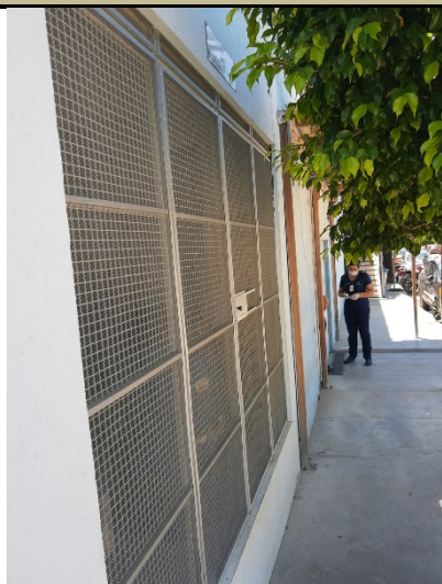
Figura – 57 Abrigos temporário de resíduos infectantes
