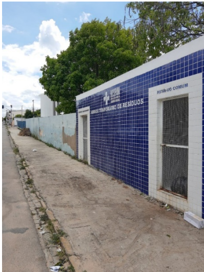
Figura – 33 Rua da coleta externa
