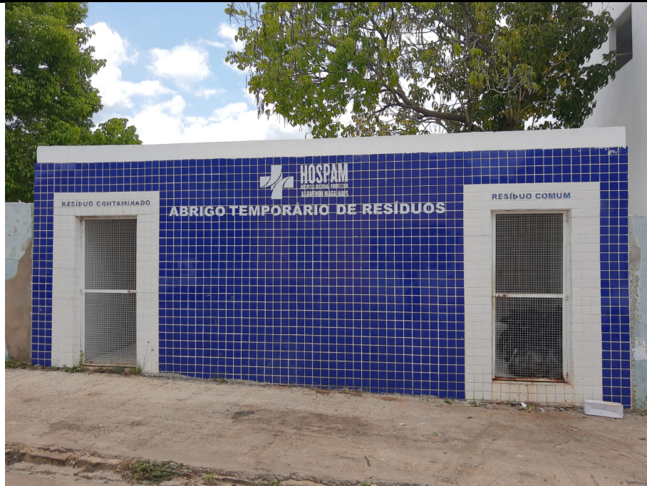
Figura – 32 Abrigo temporário acesso externo
