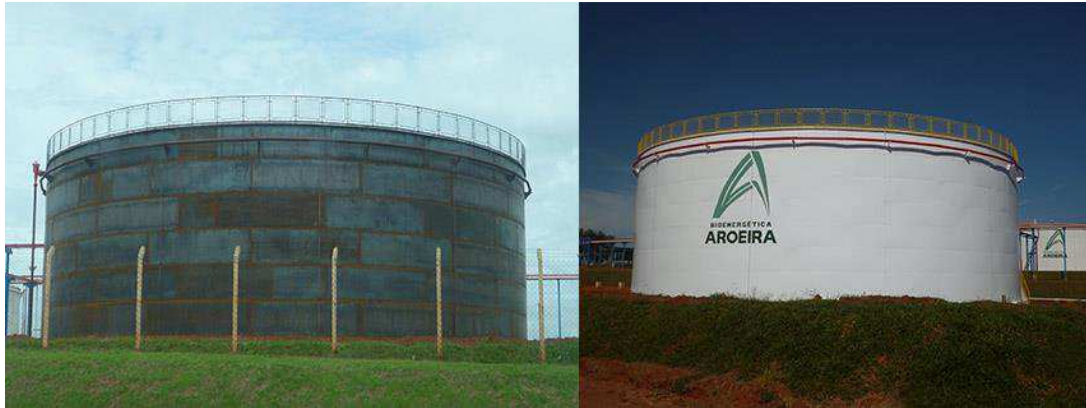
Figura 1 – Processo de Jateamento Industrial utilizado em tanque
