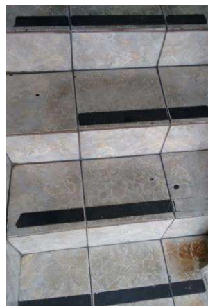
Figura 2 – Antiderrapante na escada de um ponto comercial em Delmiro Gouveia-AL
