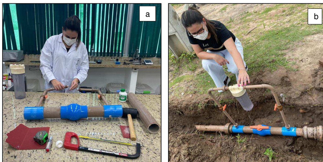
Figura 12 - Montagem do SDC
