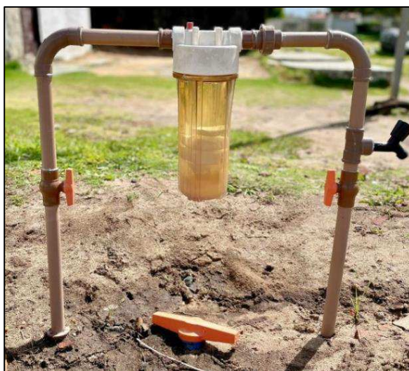
Figura 35 - Aplicação da pastilha de cloro no SDC.
