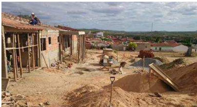
Foto 1: Canteiro de obra da pesquisa em Picuí-PB.
