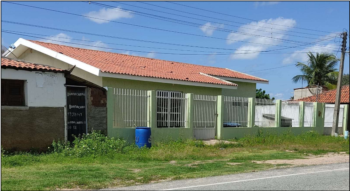
Figura 21. Posto de Saúde do Riachão das Pedras
