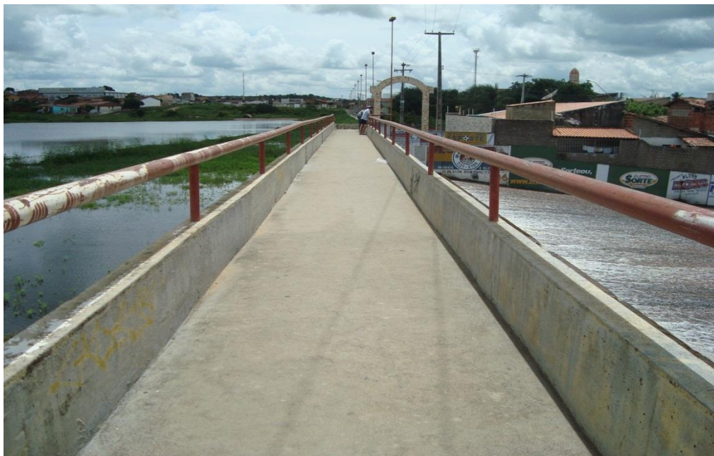
Figura 25: Nova ponte do Açude Grande
