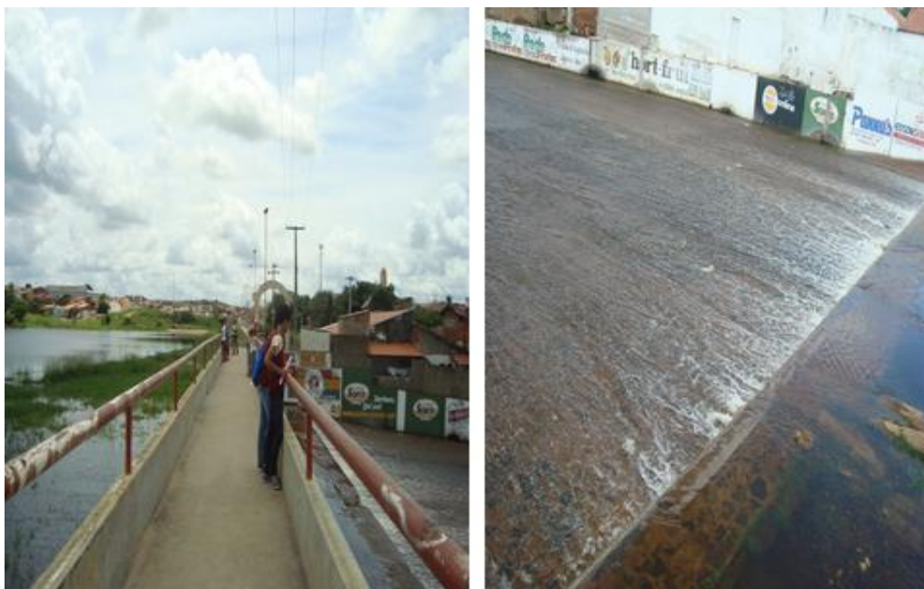
Figura 20: Ponte da sangria do Açude Grande
