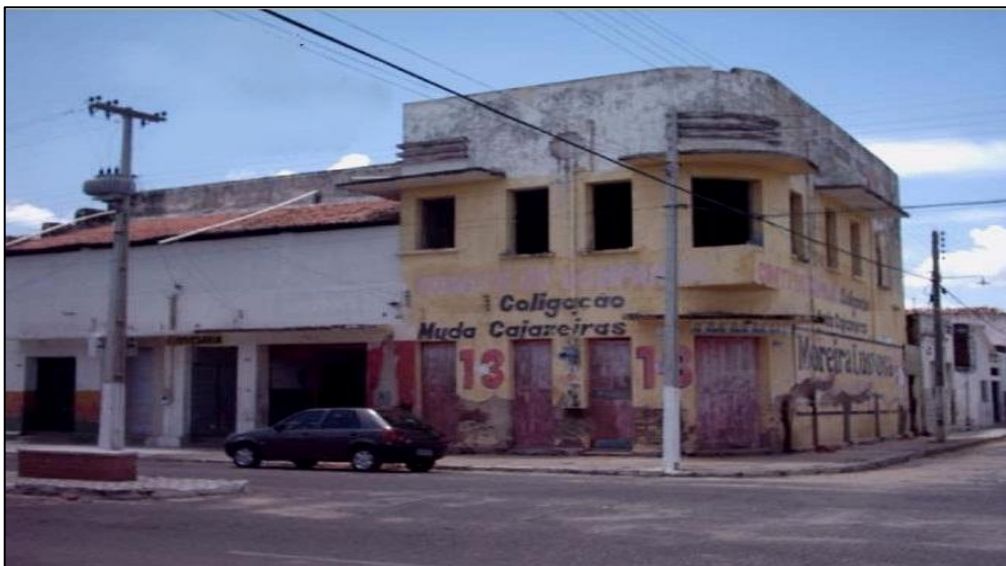
Figura14: Edifício OK – 2010 FONTE: google.com.br/search - 2014
