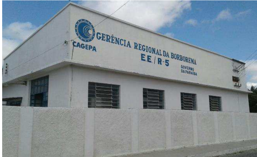
Figura 13 - Detalhe do reservatório R5
