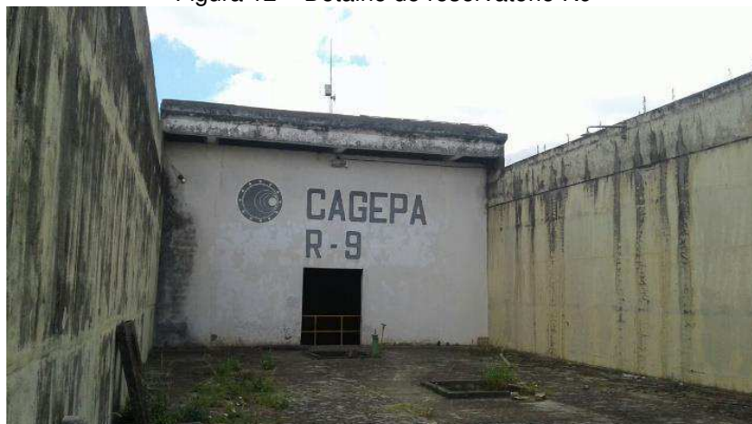
Figura 12 – Detalhe do reservatório R9
