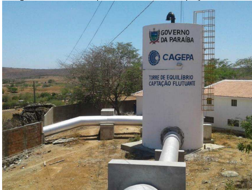
Figura 11 – Torre de equilíbrio do sistema de captação flutuante
