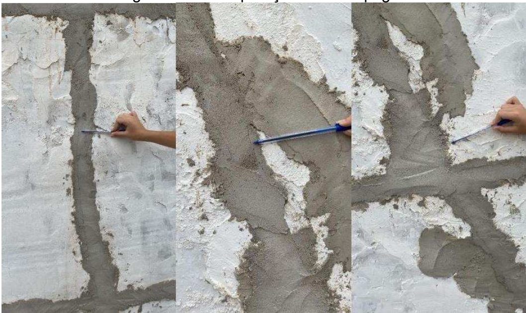
Figura 18 – Recuperação de Grampagem
