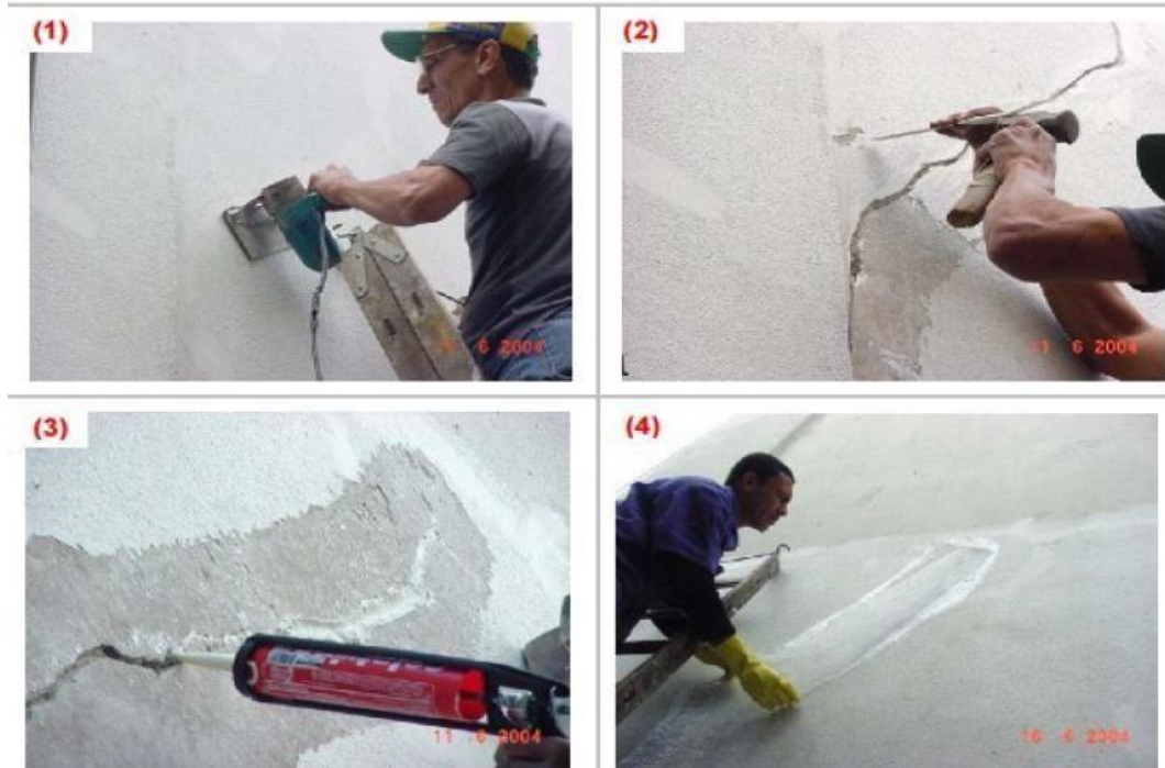
Figura 11 - (1) abertura do local fissurado com disco de corte; (2) remoção do revestimento; (3) aplicação do selante acrílico; (4) Demãos de impermeabilizante acrílico e aplicação da tela de poliéster
