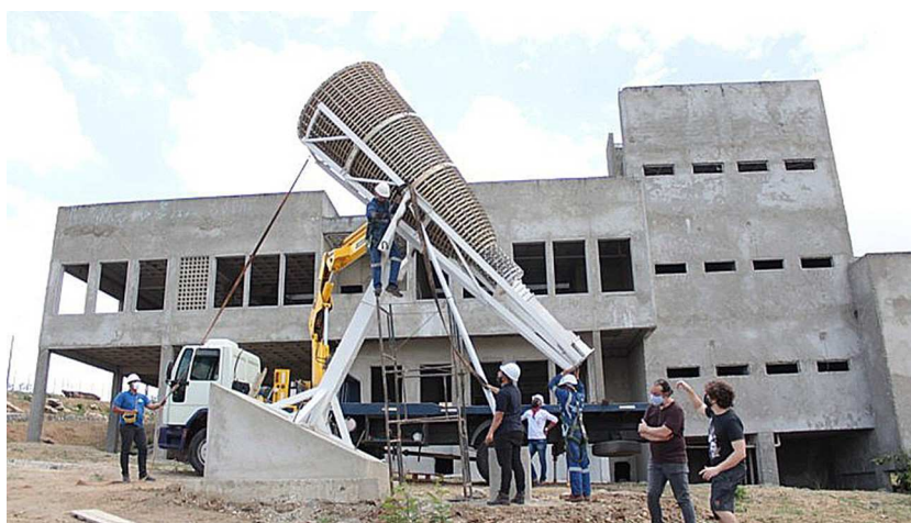
Figura 23 – Etapa de construção e instalação da corneta auxiliar na UFCG. Fonte: [12]
