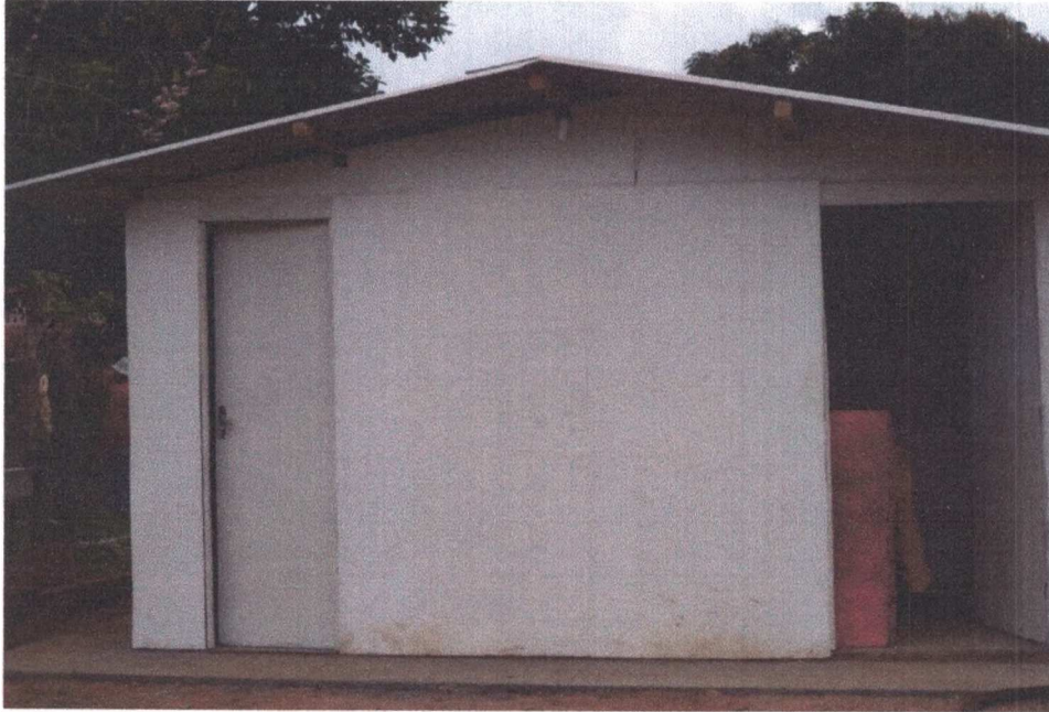
Figura 4 – Barracão da obra
