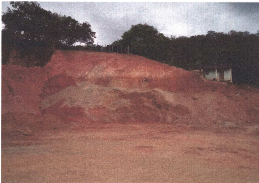
Figura 5 – Serviços de terraplenagem em finalização
