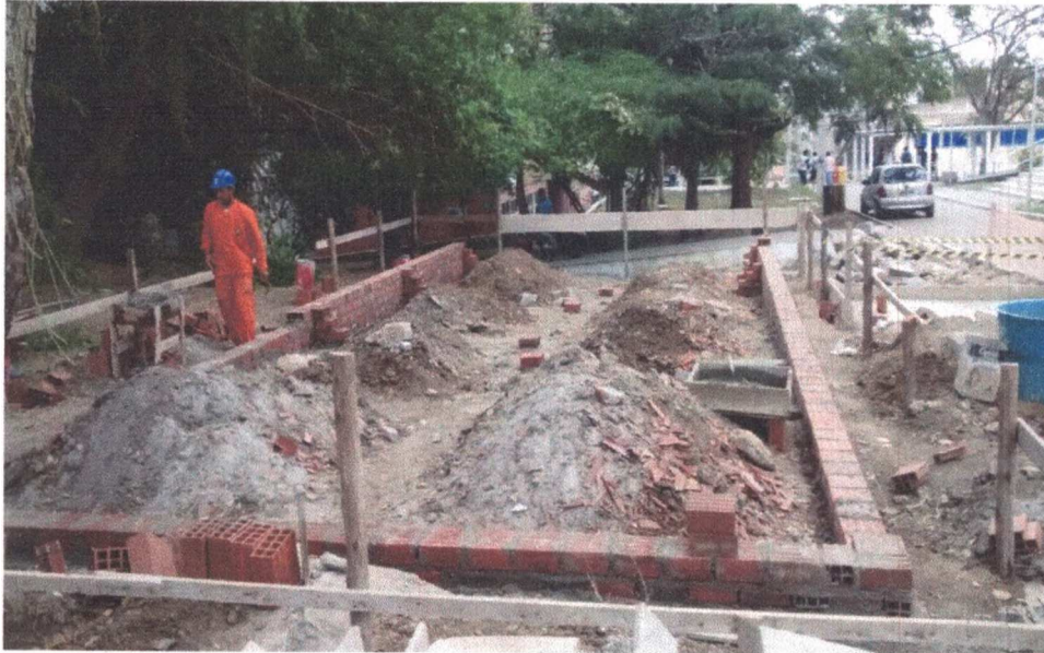
Figura 7 – Construção do barracão
