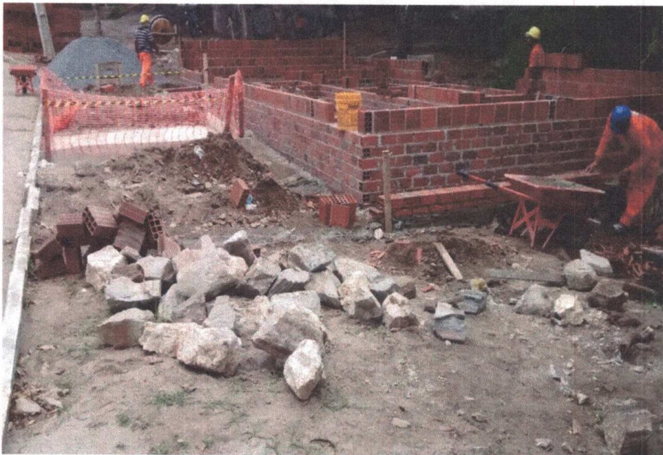
Figura 8 – Construção do barracão
