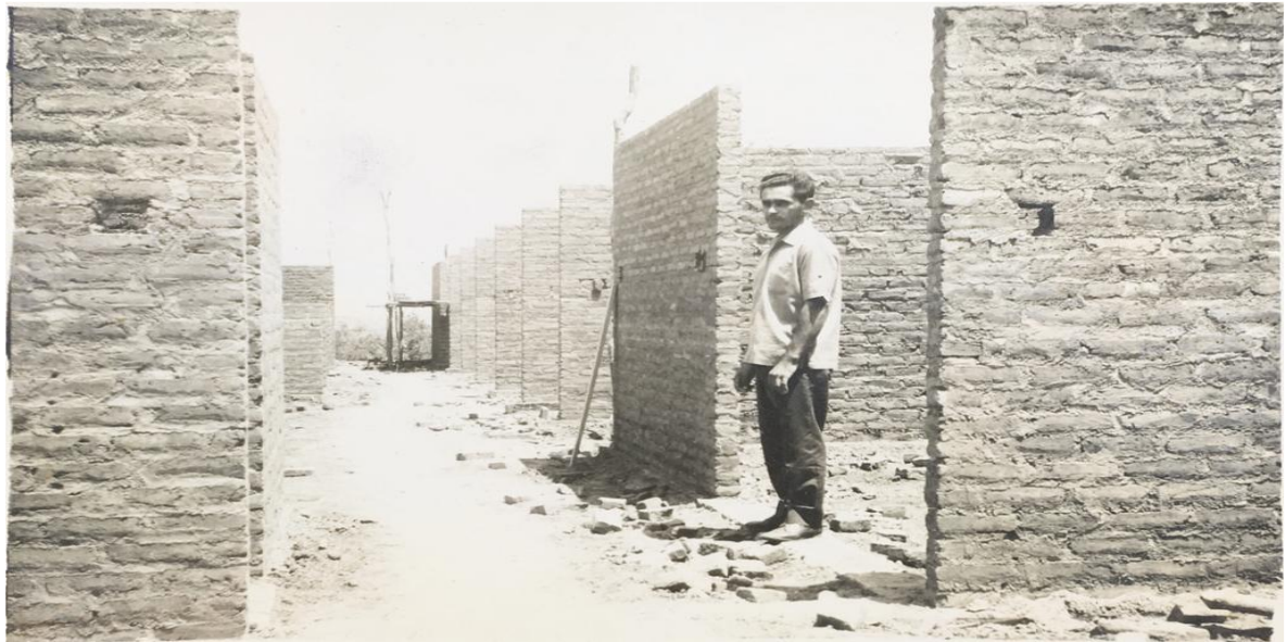
Imagem 3 - Construção do mercado público
