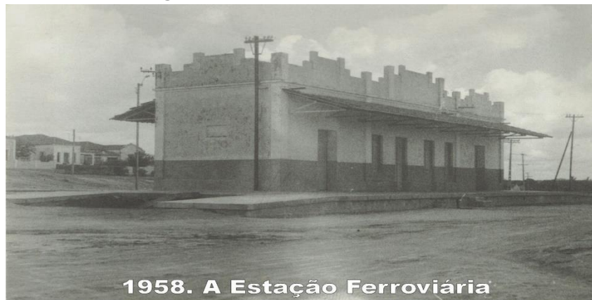
Imagem 18: Estação ferroviária de Pombal 1958
