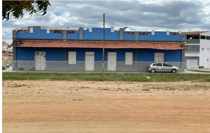
Imagem 16: Parte frontal da antiga estação ferroviária
