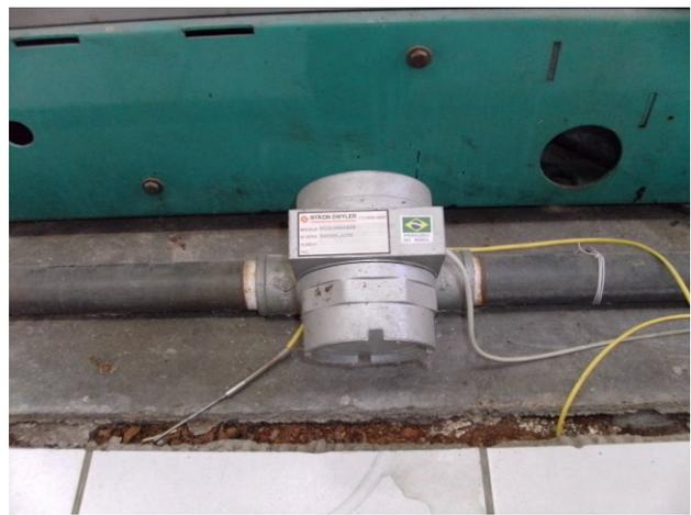
Figura 2 – Medidor de vazão de gás
