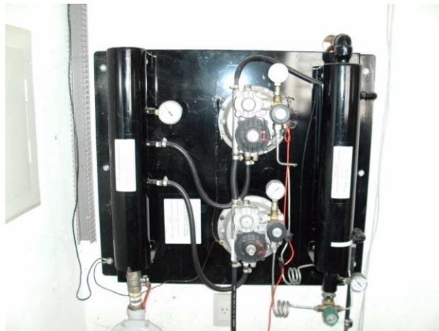
Figura 3 – Sistema de redução de pressão
