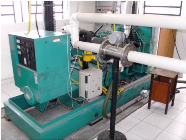
Figura 1 – Conjunto motor-gerador
