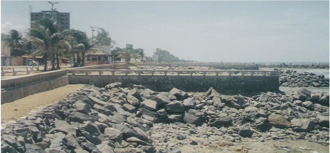
Figura 2 – Orla de Olinda, Avenida Senador Marcos Freire, onde se podem notar as obras de contenção do avanço do mar onde outrora existiam os bares que foram transferidos para o lado esquerdo da avenida.
