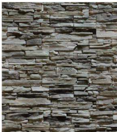
Figura 7 – Filetes de pedras canjiquinha para fachadas.
