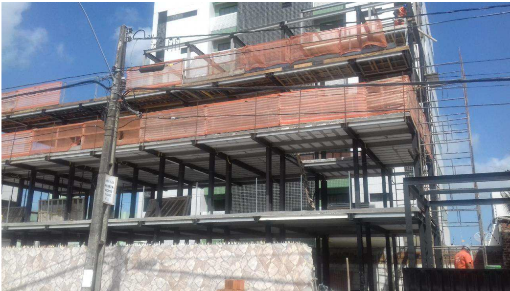
Figura 4 - Registro fotográfico da obra
