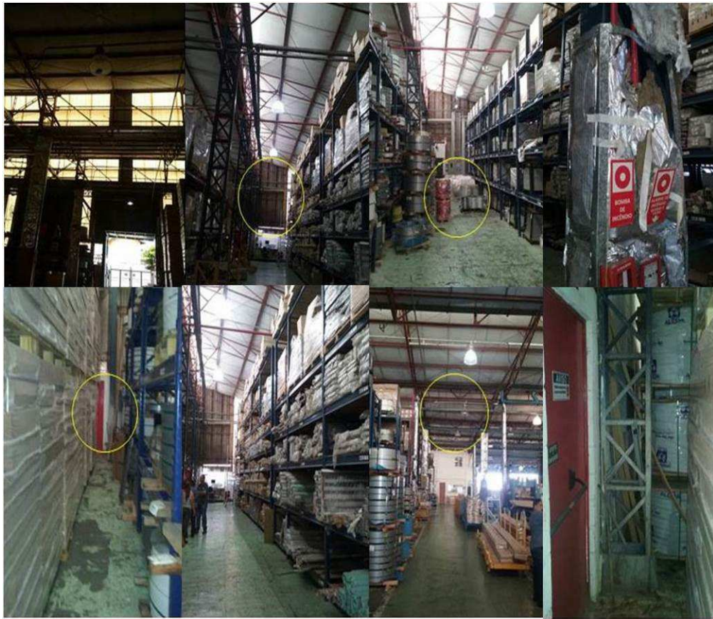
Figura 14 – Registro fotográfico dos riscos adicionais encontrados
