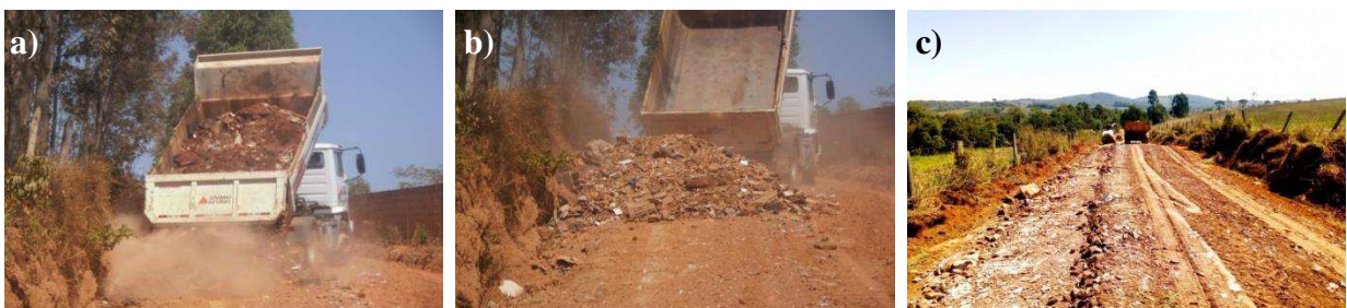
Figura 4 - Uso de RCC na manutenção de estradas rurais.
