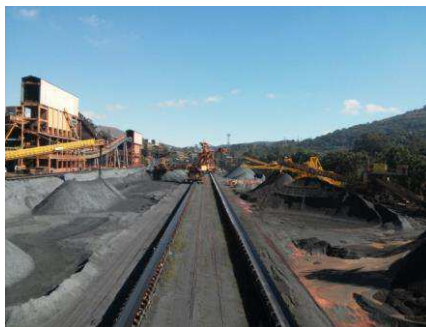
Figura 1 – Disposição dos produtos em estoque nos pátios
