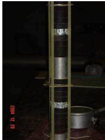
Fig. 50 – Varistores com defeito.
