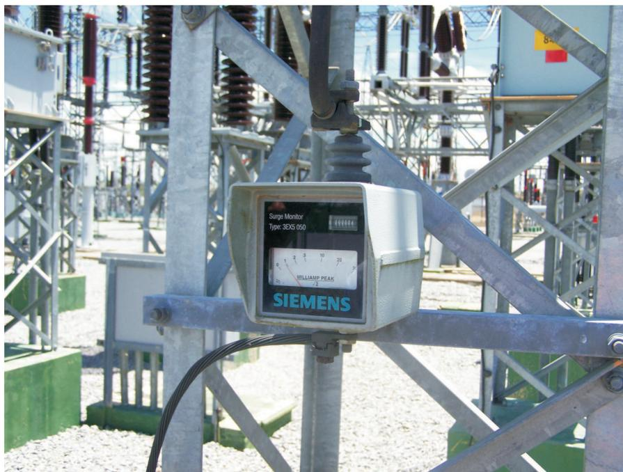
**Figura 3.1** – Miliamperímetro instalado permanentemente em para-raios de ZnO.
