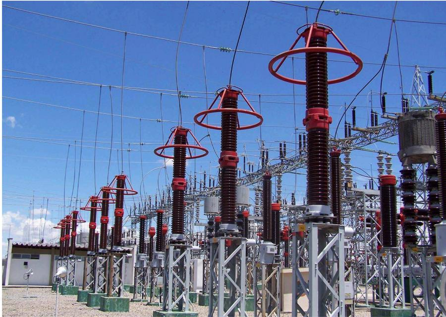
**Figura 2.1** – Foto da localização de um para-raios em uma subestação de 230kV - CGII-CHESF.
