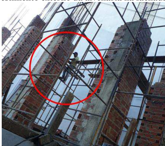
Figura 3. Revestimento externo da alvenaria na fachada da edificação
