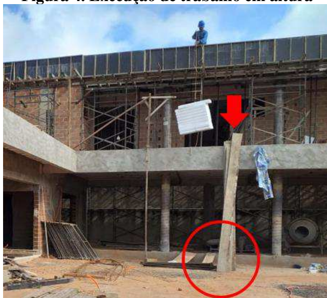
Figura 4. Execução de trabalho em altura
