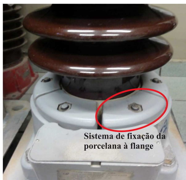
Figura 4.3 – Fotografia do sistema de fixação da porcelana à flange.
