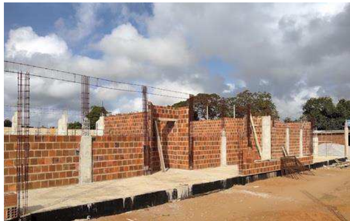
Figura 1: Imagem do processo de elevação da alvenaria de vedação externa.
