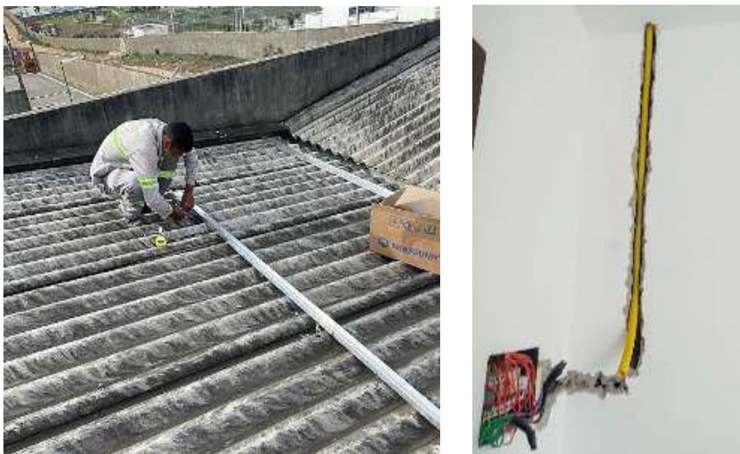
Figura 11 – Detalhes da instalação.
