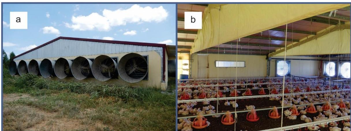
Figura 5. Exaustores localizados no oitão Oeste (a) e na parede voltada ao Sul.
