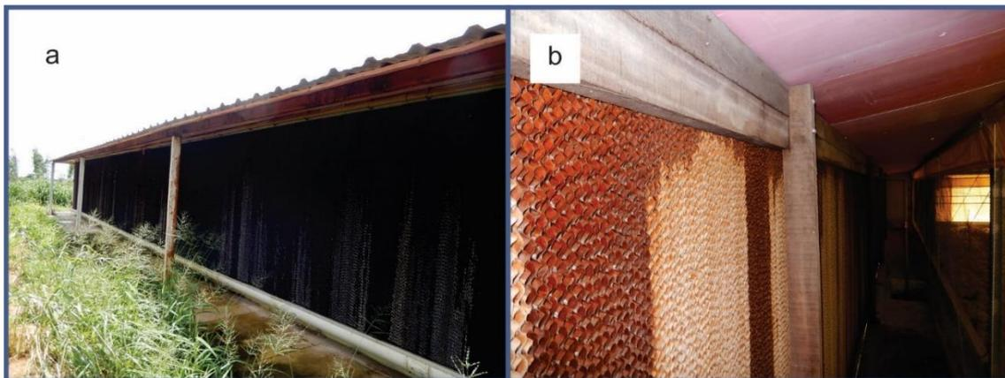
Figura 3. Vista exterior do painel evaporativo (a) e vista interior da circulação entre o painel e a área de alojamento das aves (b).
