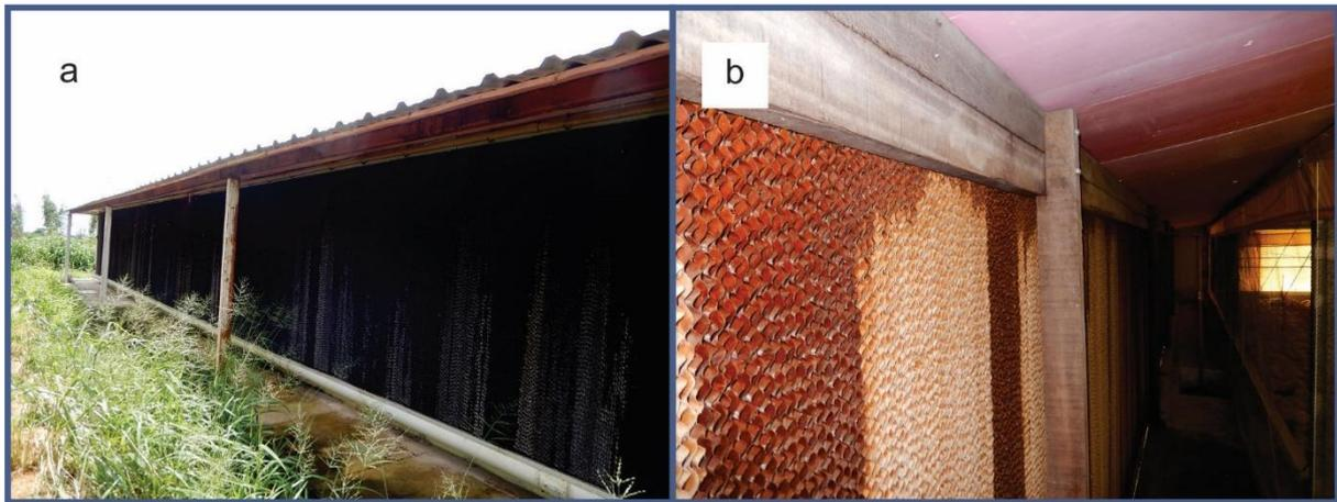
Figura 4. Vista exterior do painel evaporativo (a) e vista interior da circulação entre o painel e a área de alojamento das aves (b).
