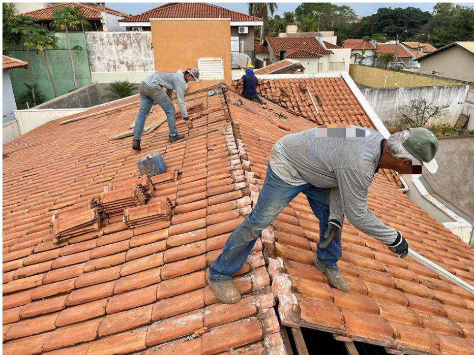
Portanto segundo determina a NR 35, no processo de montagem de um telhado devemos utilizar sistema de proteção contra queda (SPCQ), montando uma linha de vida de corda em dois sentidos, uma na diagonal e outro no ponto fixo, evitando assim a queda do
