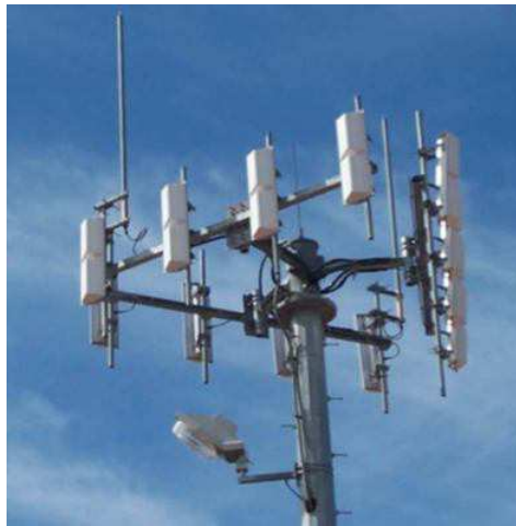
Figura 8- Arranjo triangular de dipolos usado como antena setorial de estação-base para comunicação móvel.
