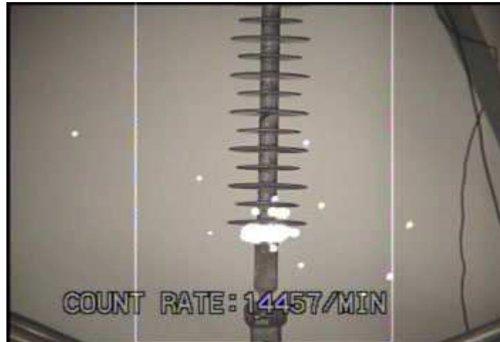
Figura 4.35. Imagem detectada pela câmera UV para isolador com defeito e poluição nível 3.
