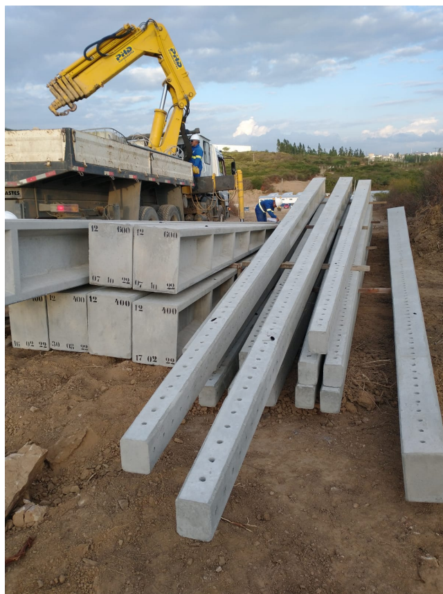
Figura 29 – Descarrego dos postes para obra
