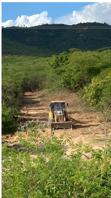
(a) Área limpa para passagem da rede
