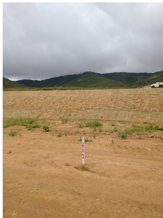
(b) Poste do ponto de entrega locado in loco
