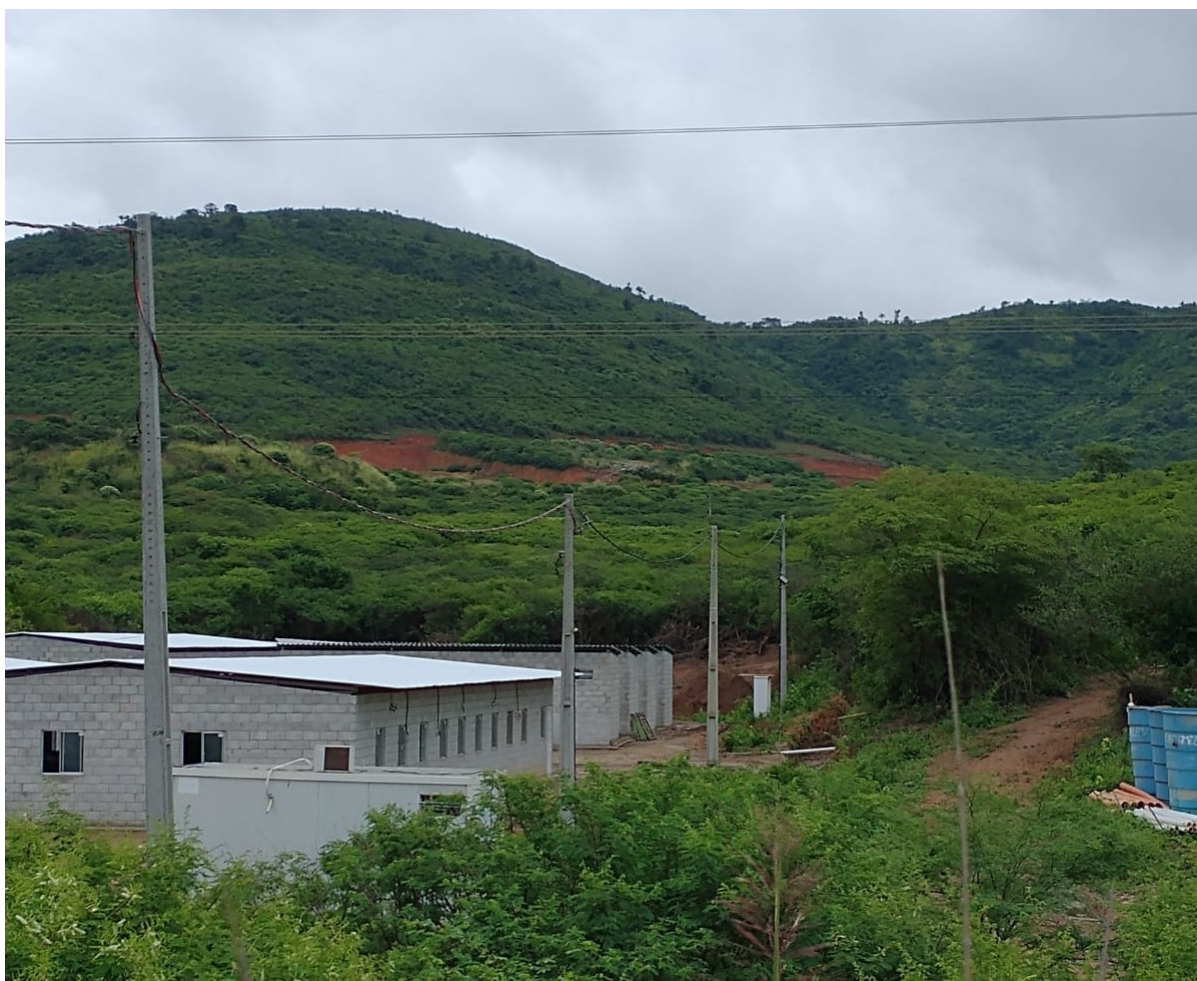
Figura 16 – Obra executada - rede elétrica do canteiro de obras
