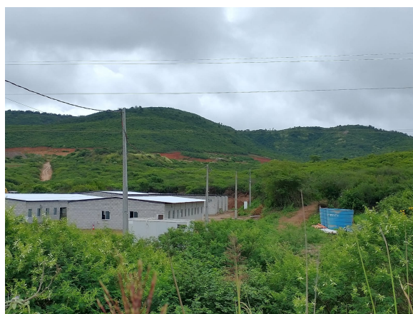
(a) Edificações do canteiro de obras
