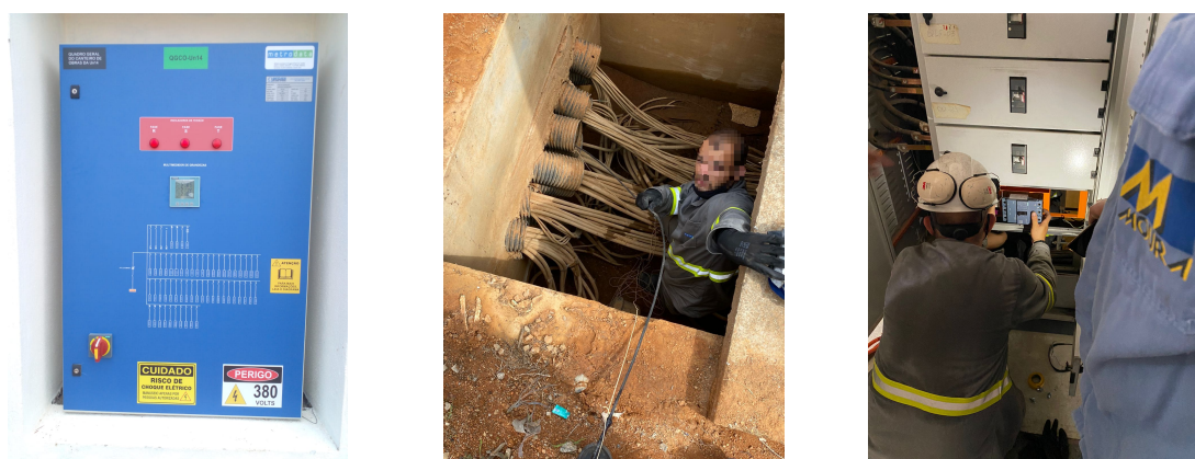
(a) Quadro elétrico instalado (b) Passagem dos cabos (c) Instalação do disjuntor
