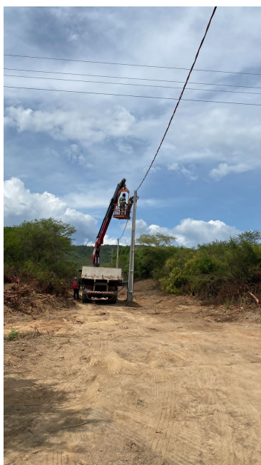
(a) Passagem dos cabos aéreos
