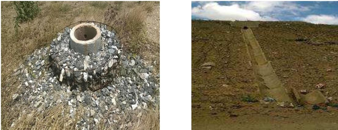
Figura 3. Drenos de gás e de água de superfície.
