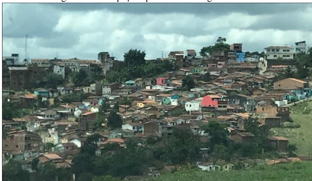
Figura 26 – Ocupações precárias ao longo de encostas
