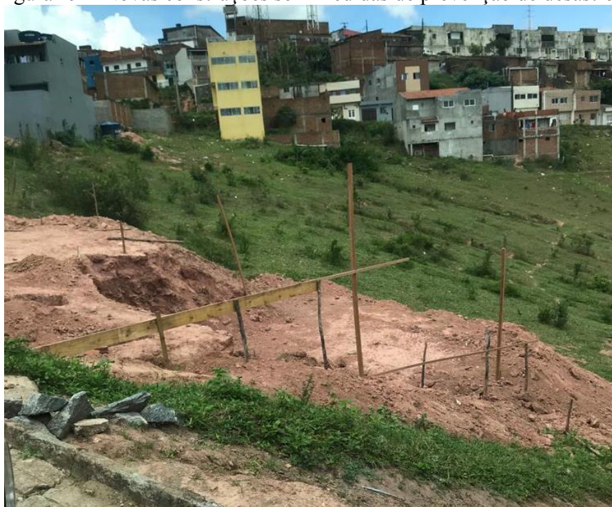
Figura 29 – Novas construções sem medidas de prevenção de desastres.
