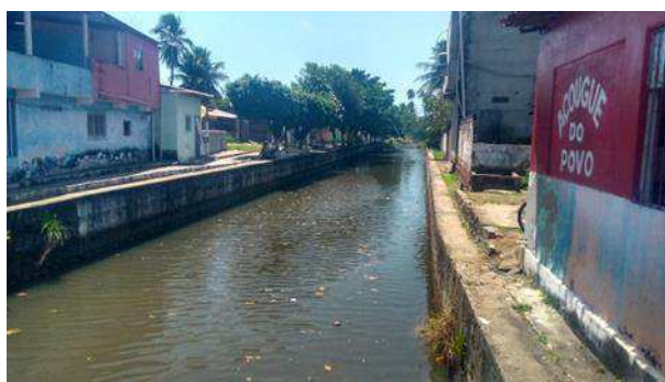
Figura 5. Trecho do Rio Maceió sem resíduos sólidos depositado na faixa urbana.
