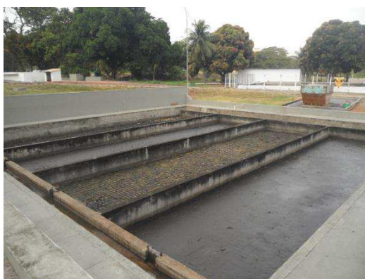
Figura 2. Unidade do leito de secagem do lodo.
