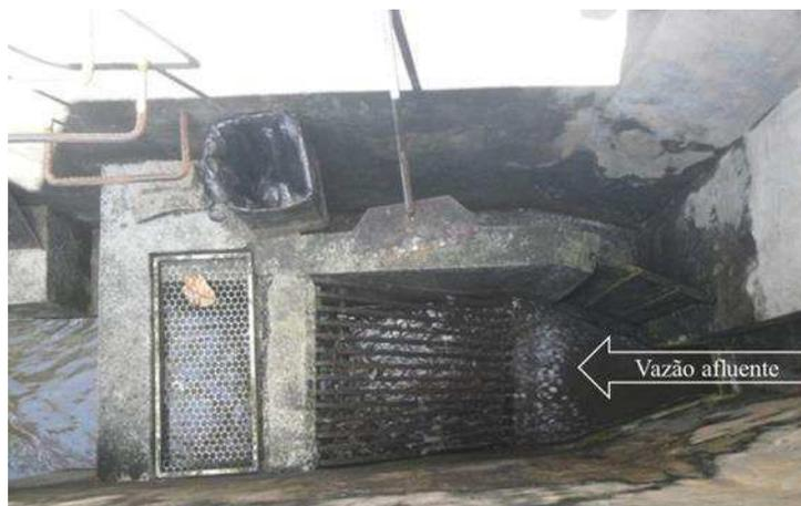
Figura 2. Unidade de remoção de sólidos grosseiros: gradeamento, bandeja, rastelo e saco plástico.
