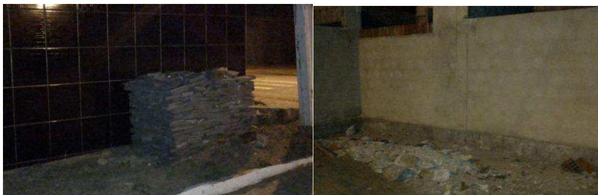
Figura 1. Obras de construção e reforma realizadas na sede do Município, referente a reformas de residências e a construção de órgãos municipais.
