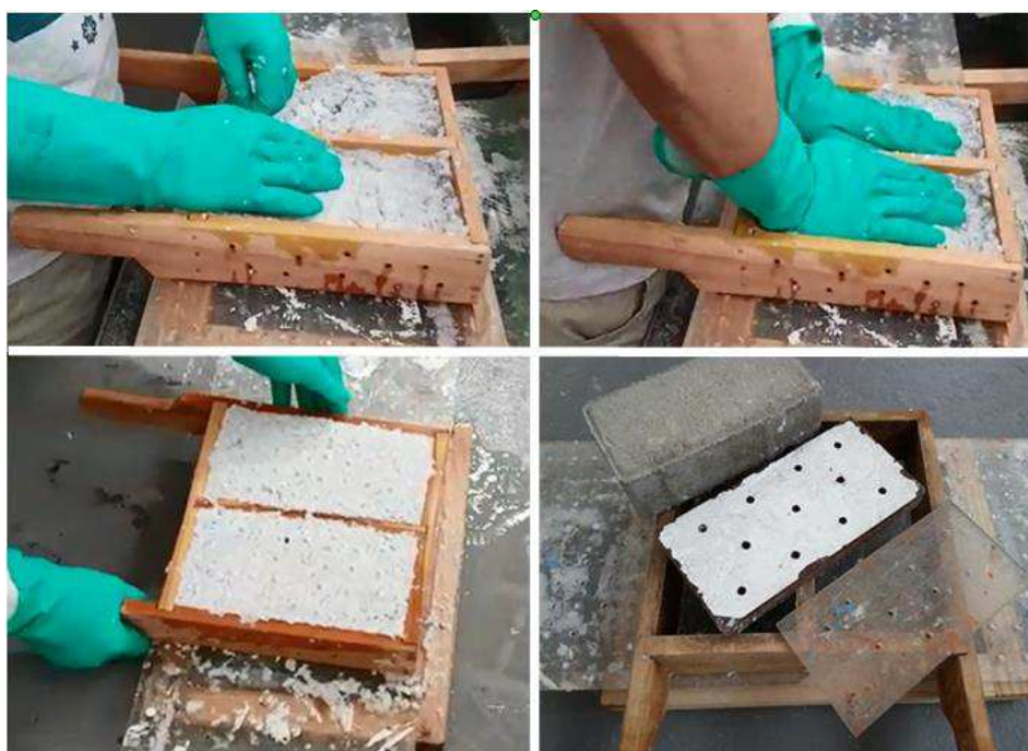
Figura 1. Processo da prensagem da massa na fôrma.
