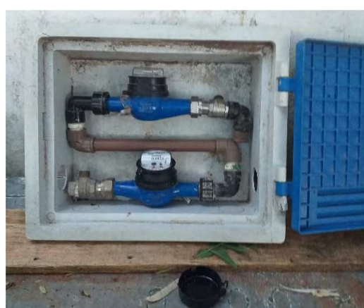
(B) – Modelo onde o medido ficou inclinado
