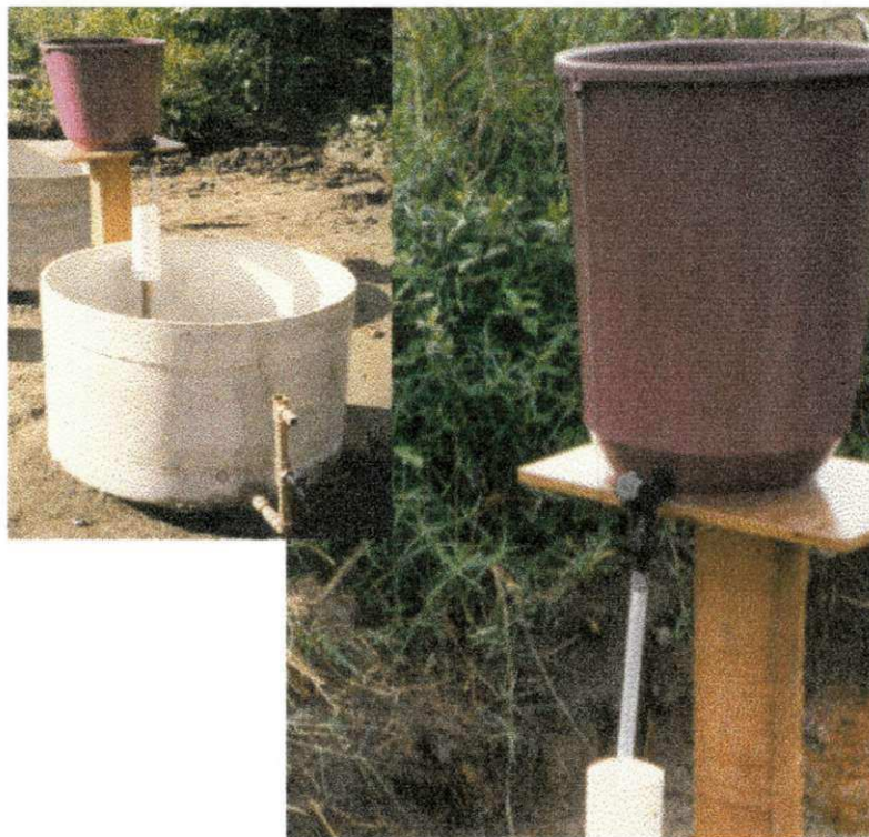
Figura 4.2 – Dispositivo de alimentação para os tanques dos sistemas de terras úmidas construídas.
