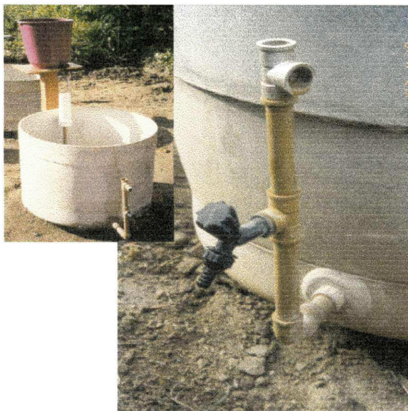
Figura 4.4 – Dispositivo de saída para os tanques dos sistemas de terras úmidas construídas.
